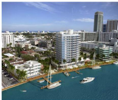
Εικόνα 20. The Capri, Miami Bay, USA. Υπόγεια κατασκευή με PENETRON ADMIX®
