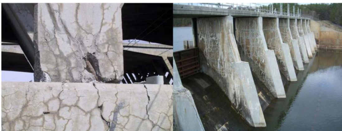
Εικόνα 8. Παραδείγματα φθοράς από αλκαλοπυριτική αντίδραση (ASR)
