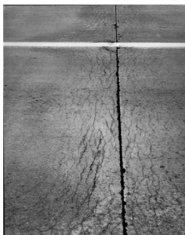
Εικόνα 5. Παράδειγμα D-cracking
