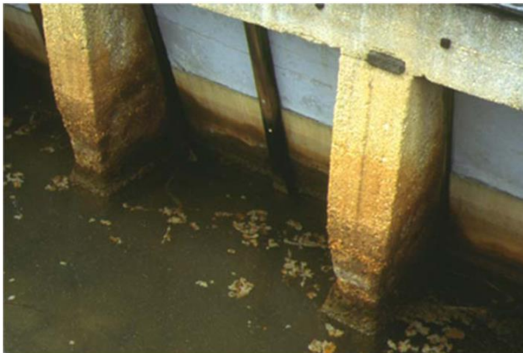
Εικόνα 10. Παράδειγμα φθοράς σε σκυρόδεμα που προκλήθηκε από χημική προσβολή
