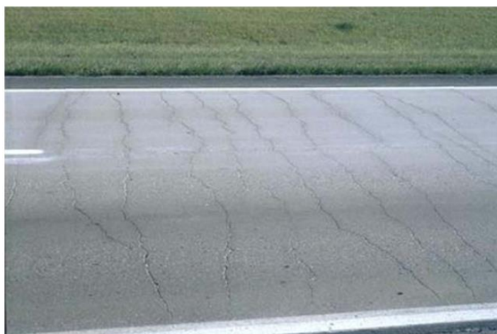
Εικόνα 4. Παράδειγμα θερμικής ρωγμάτωσης
