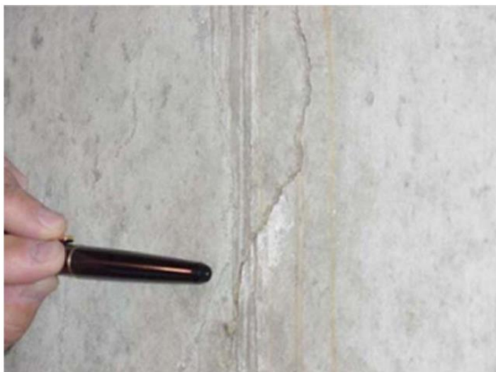
Εικόνα 2. Παράδειγμα ρωγμών πλαστικής συρρίκνωσης
